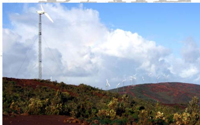
Ferme d'éoliennes au col de Prony.
